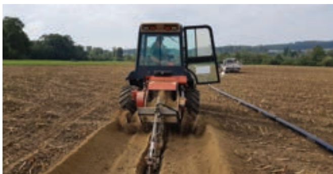
Construction de conduites au sol, soudées en PE ou manchonnées en PVC. Essai de pression inclus!
