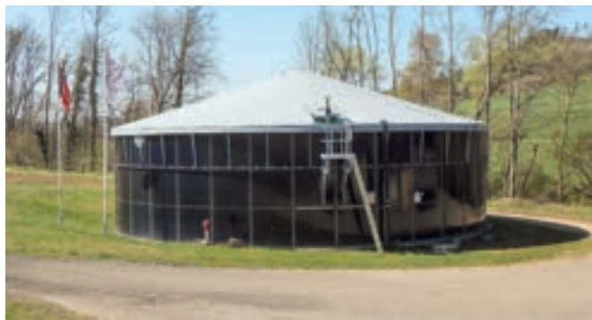
Couverture à éléments creux en béton précontraint
