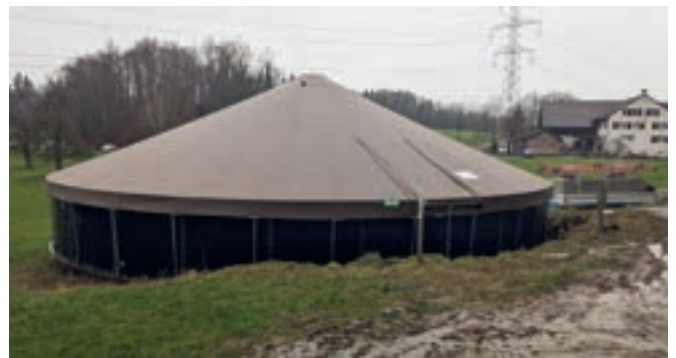
Toit à double membrane pour les installations de biogaz
